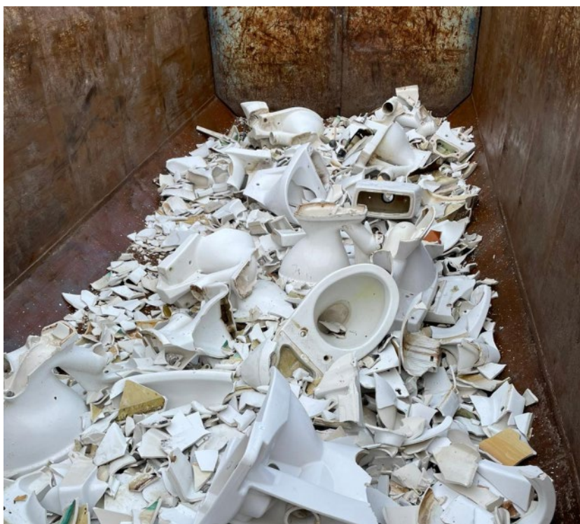
Kuva 1. Forssan kohteessa purettua ja erilliskerättyä saniteettikalustejätettä (Kuva Janne Salonen)
