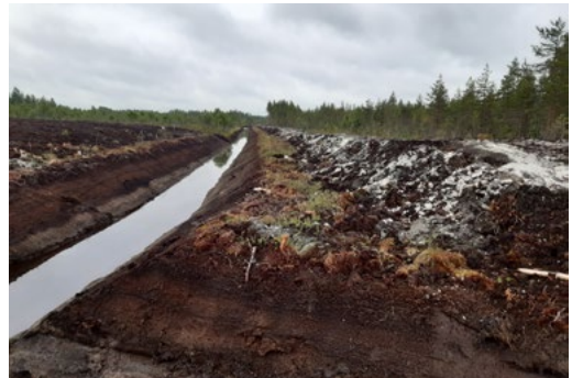
Oulun Välimaalla vesiensuojelurakenteen kaivuutöiden yhteydessä havaittu hapan sulfaattimaa kalkittiin happamien valumavesien synnyn estämiseksi.
